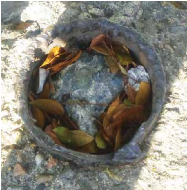
Desecho de tubo de metal de 8 pulgadas de diámetro, con bordes afilados. Fuente: todas las fotos que figuran en este artículo fueron tomadas por el autor del mismo.
