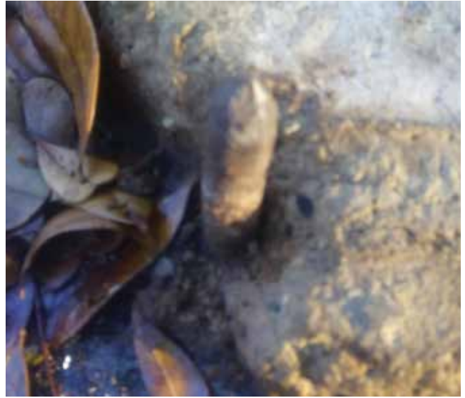
Vástago puntiagudo sobresaliendo tres pulgadas sobre la acera.
