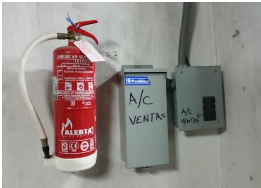
Anexo 10. Extintor colocado al lado de una caja de breakers eléctricos.
