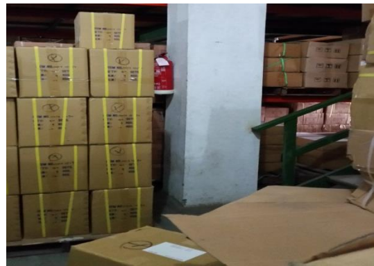
Anexo 11. Extintor colocado en un sitio no visible, y obstaculizado por mercancía.
