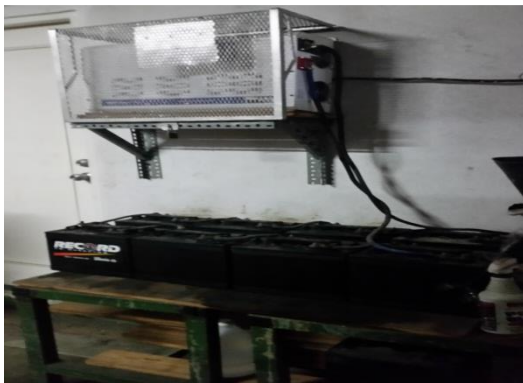
Anexo 18. Baterías e inversor. Piso 2.
