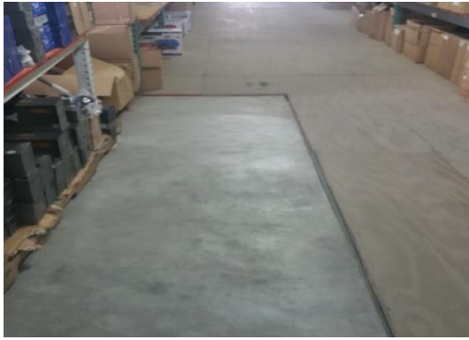
Anexo 14. Desnivel piso 2 del almacén.
