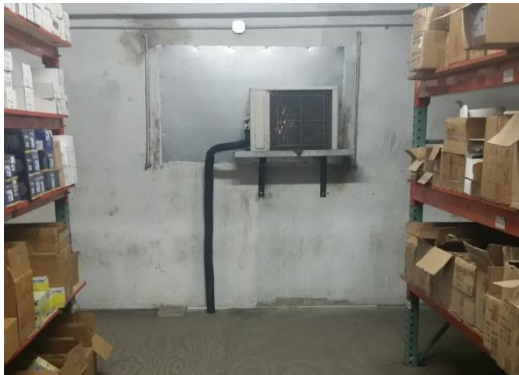
Anexo 16. Compresor de aire acondicionado.
