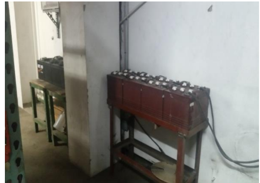
Anexo 17. Baterías de Inversor.
