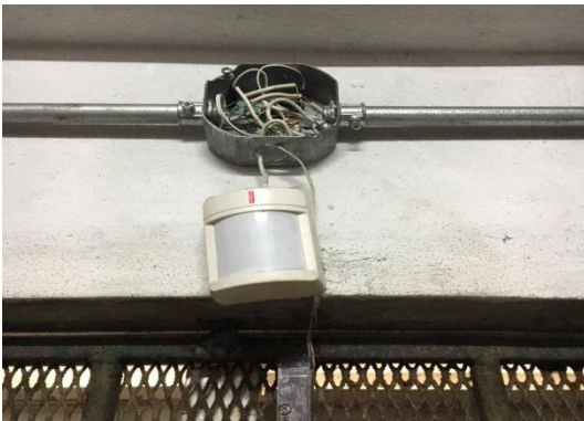
Anexo 6. Cables eléctricos expuestos.
