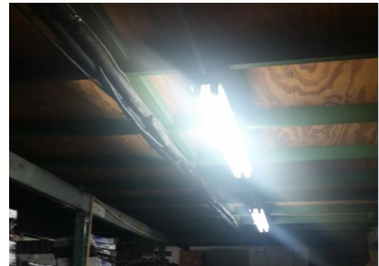
Anexo 7. Cables con canaletas defectuosas.
