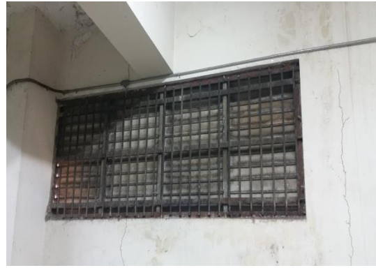
Anexo 9. Ventanas selladas del almacén (Primer nivel).
