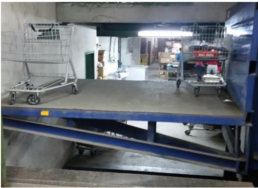
Anexo 4. Ascensor sin puerta, vista desde la parte más alta del primer nivel.
