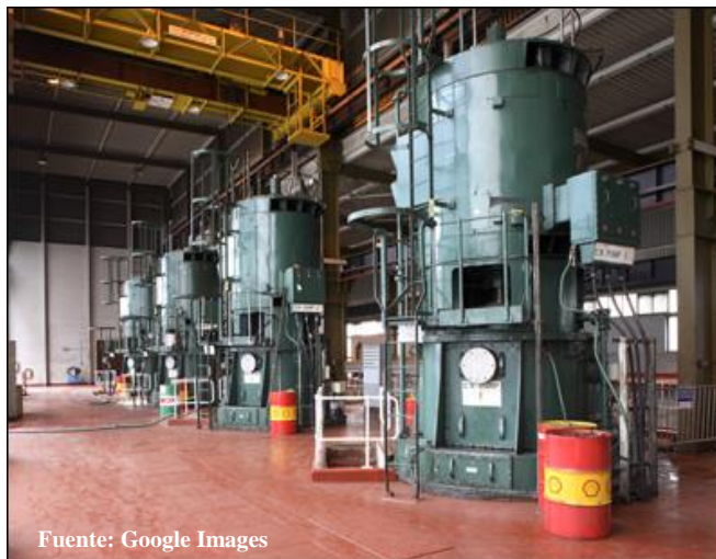
Figura 4.17: Bombas Agua Circulación Condensador.
