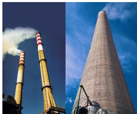
Figura 5.12: Chimeneas metálica y de hormigón armado.
