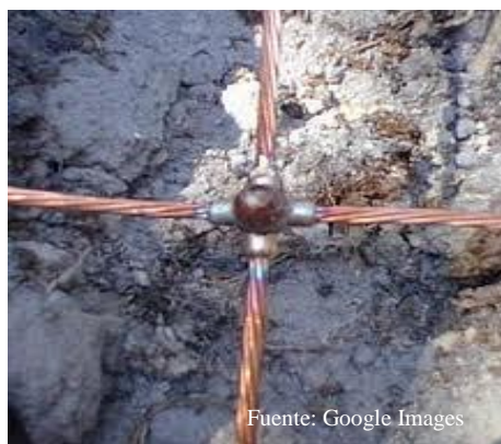
Figura 11.03: Unión por soldadura Cadweld.
