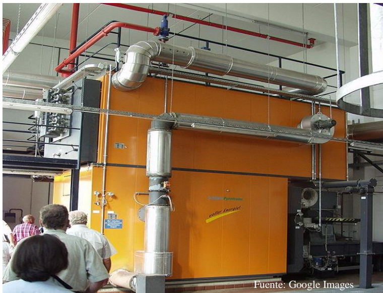
Figura 1.14 Caldera de combustión de biomasa
