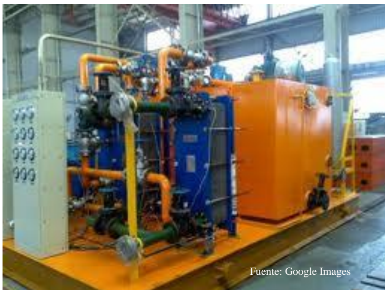
Figura 6.17: Equipo enfriamiento y filtrado aceite turbina de gas.
