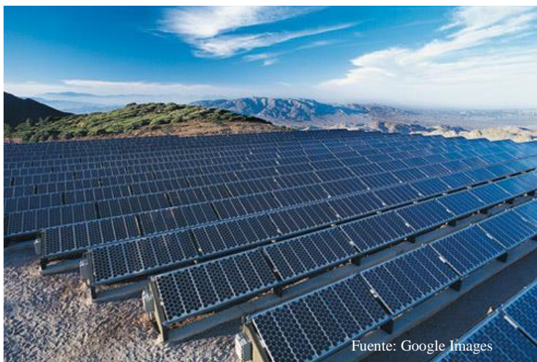
Figura 1.13: Central solar fotovoltaica.
