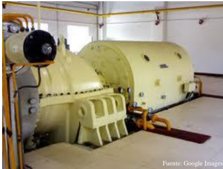
Figura 5.17: Turbina de vapor acoplada a su generador eléctrico.
