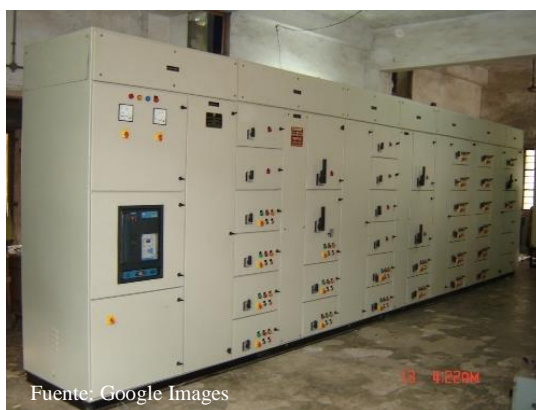
Figura 4.19: Centro Control Motores (CCM) a baja tensión.
