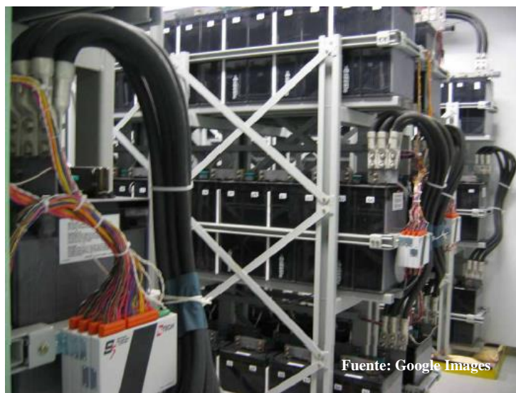
Figura 4.24: Bancos de baterías.
