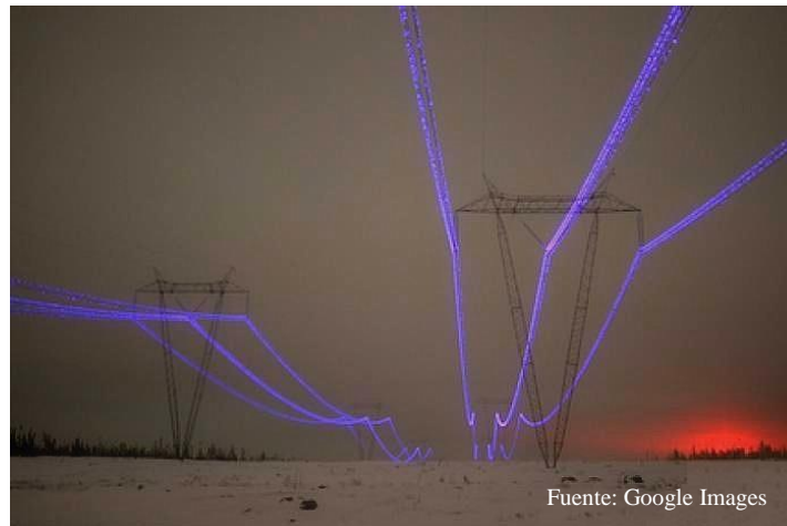
Figura 12.05: Efecto corona en una red de transmisión a 500 kV.
