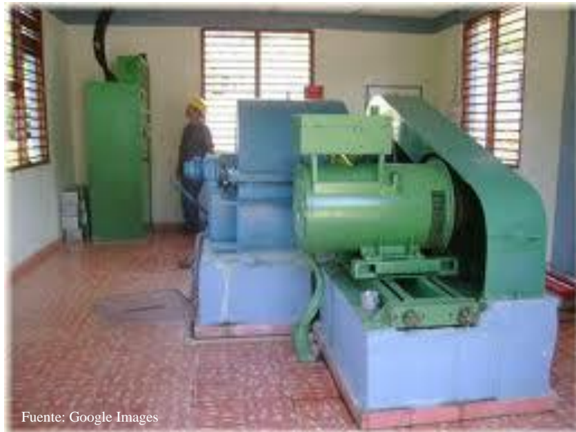
Figura 8.28: Casa máquinas pequeña central hidroeléctrica.
