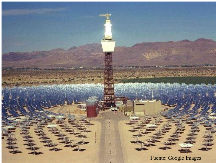
Figura 1.12 Central solar térmica.
