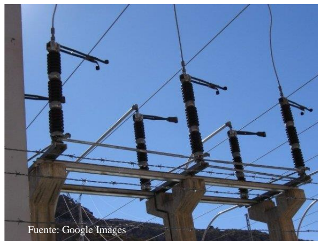
Figura 10.07: Seccionador doble columna giratoria.
