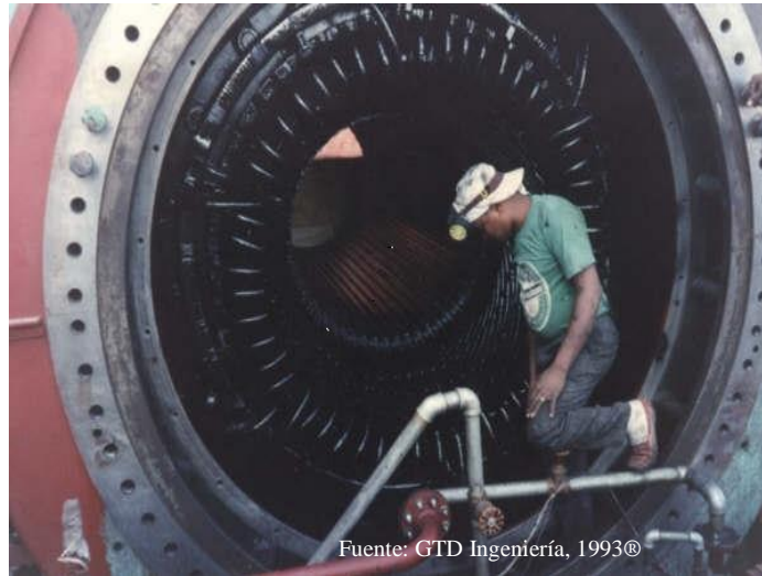
Figura 2.01: Armadura o estator generador trifásico sincrónico 54 MW @ 13.8 kV.
