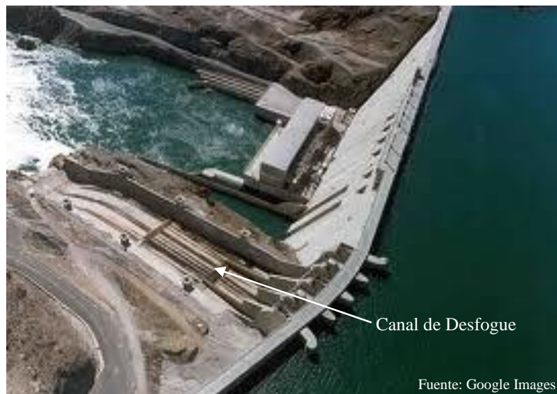
Figura 8.11: Canal desfogue presa hormigón de gravedad.
