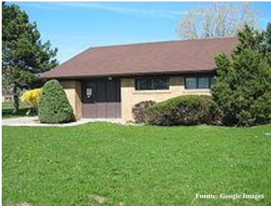
Figura 9.04: Subestación de distribución primaria para interiores.
