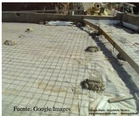
Figura 11.02: Malla puesta a tierra
