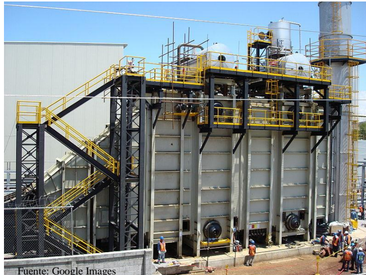
Figura 1.05: Generador de Vapor de Recuperación de Calor (HRSG)
