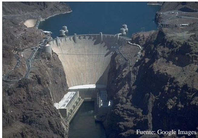
Figura 8.08: Presa Hoover, tipo bóveda, Arizona y Nevada, Estados Unidos.
