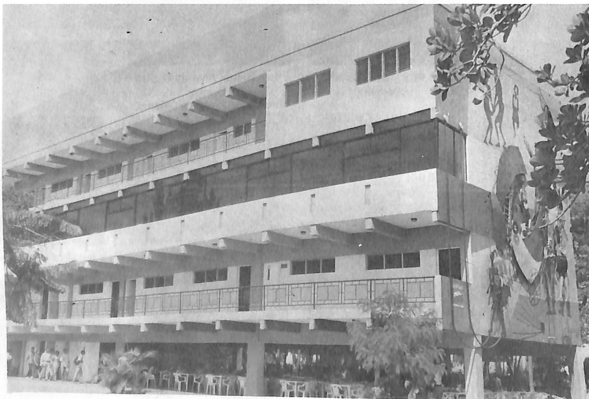
Edificio II. En el primer nivel se observa la Terraza de Estudiantes. El tercer nivel aloja las instalaciones de la Biblioteca
