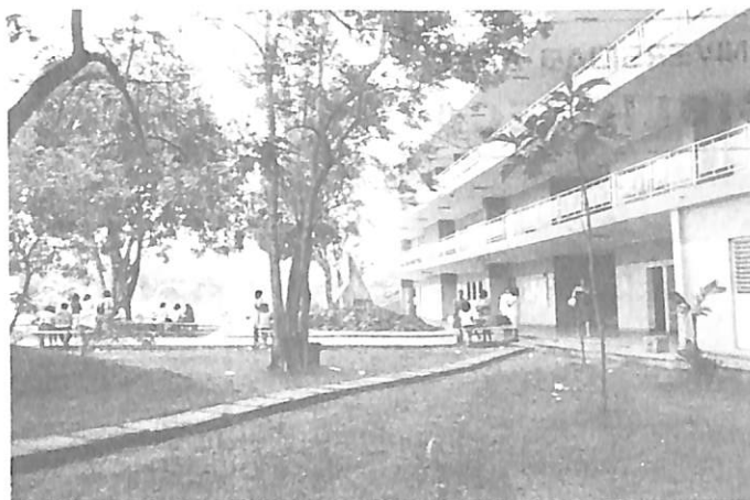
Vista parcial del Edificio I, el cual aloja aulas y oficinas Académicas y Administrativas, al frente se observa el Monumento dedicado al Patricio Juan Pablo Duarte, Al fondo, el Edificio que aloja las Oficinas de la Rectoría.
