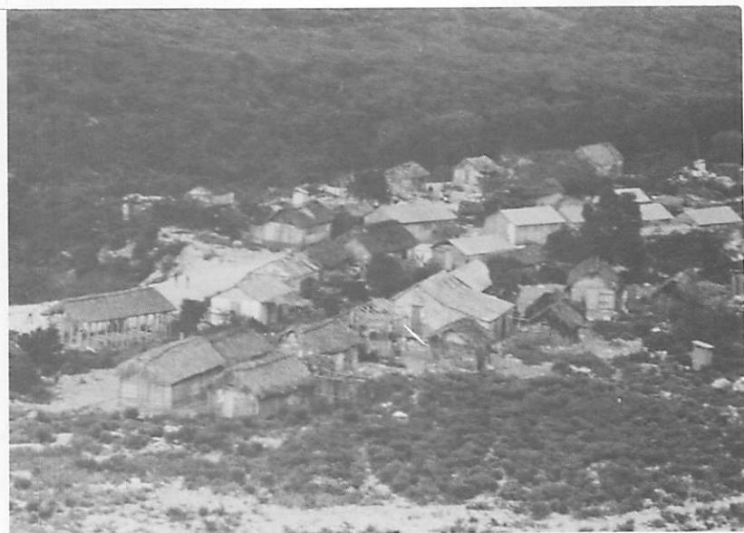
Fig. 16. Vista panorámica de parte del sector de "Mordán".
