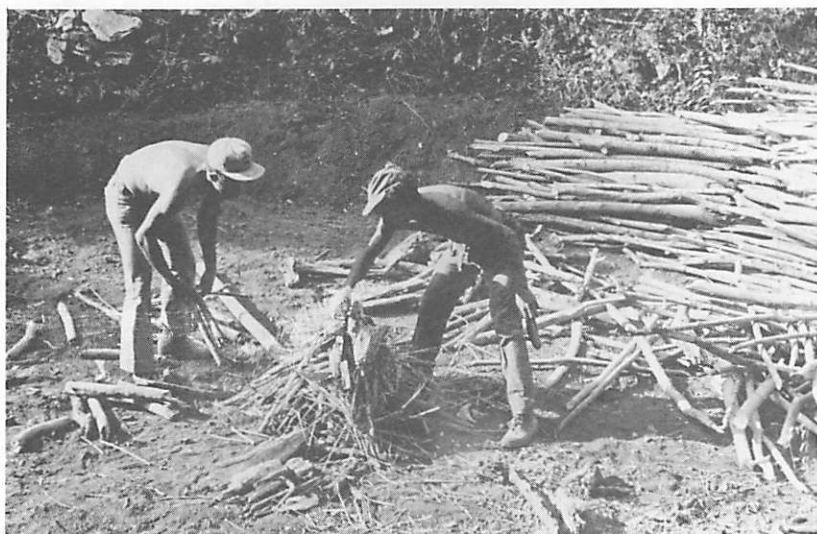
Fig. 30. Para "montar" el horno se comienza colocando un fondo de paja, a fin de facilitar prenderlo cuando este terminado.
