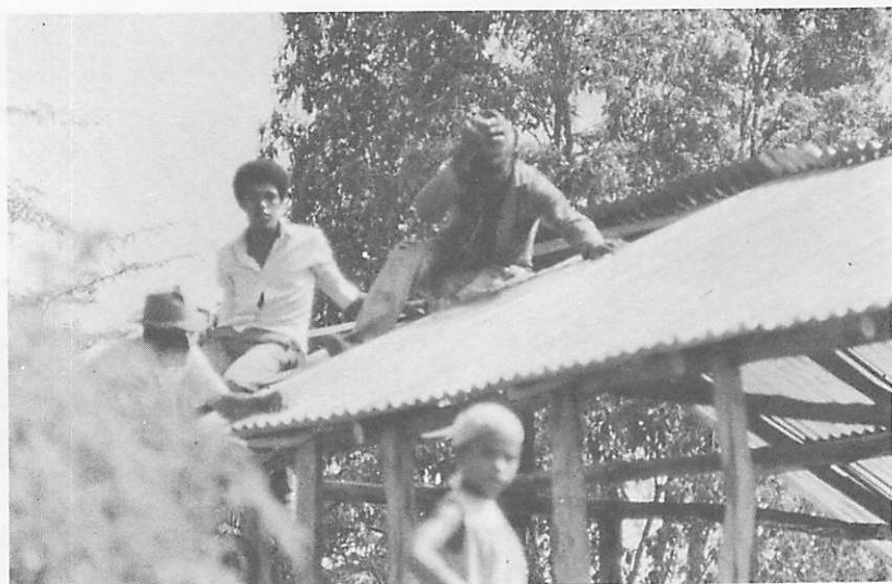
Fig. 47. Construcción de una casa de madera con techo de zinc.
