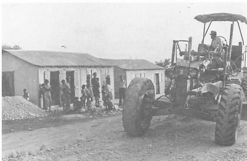
Fig. 70. Trabajo de reparación del camino vecinal que termina formando la única calle del poblado.
