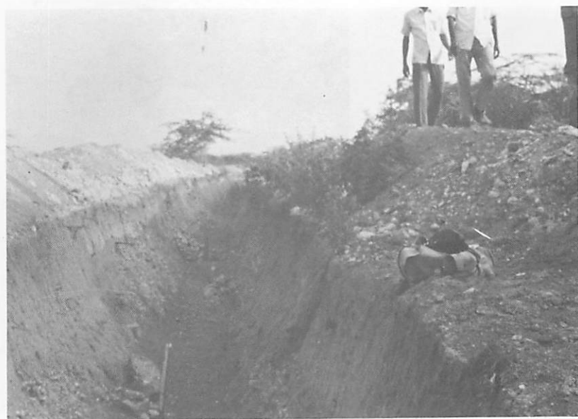
Fig. 65. Una vista del canal en construcción.
