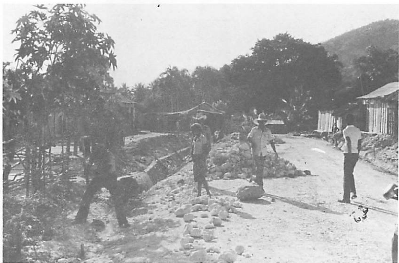
Fig. 71. Otra vista de la reparación de la calle y de la construcción de zanjas de drenaje.
