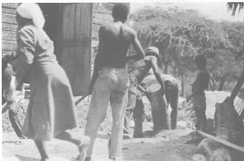
Fig. 67. Trabajo de albañilería para ponerle piso de cemento a la casa que se ve al fondo.
