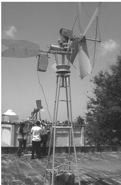
Aerogenerador Wilcapec2 de 2 metros de diámetro en Aspas.
