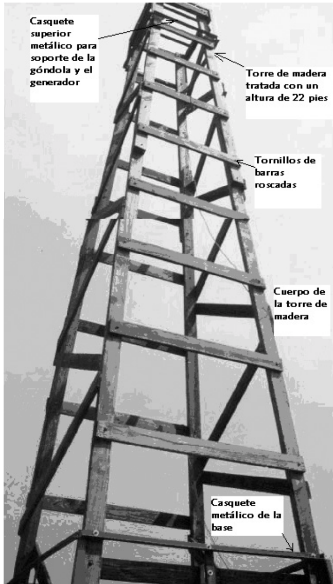
Detalles de la torre antes de montar el generador
